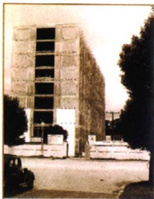
O Palácio das Indústrias em construção, nos anos 60
